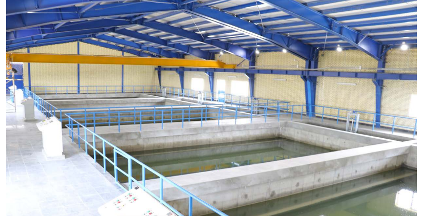
مدول سوم تصفیه خانه آب شماره ۲ کرج
